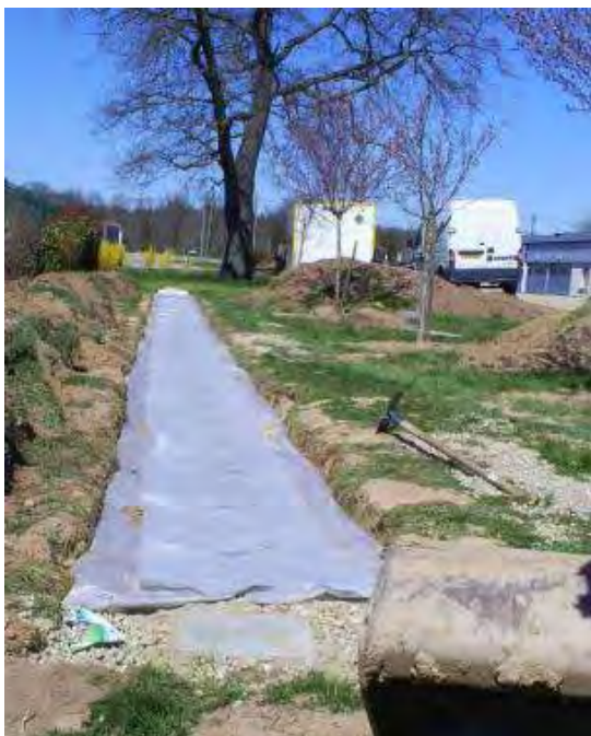
Fermeture du géotextile
