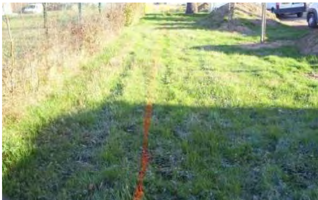
Marquage au sol
