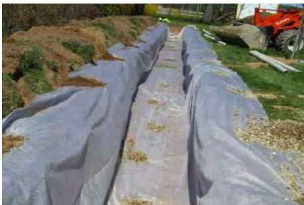
Mise en place du géotextile
