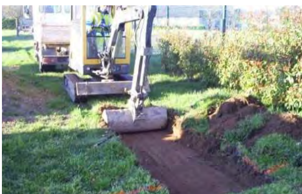
Décapage de la terre végétale
