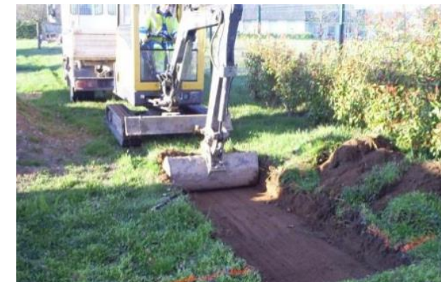
Décapage de la terre végétale
