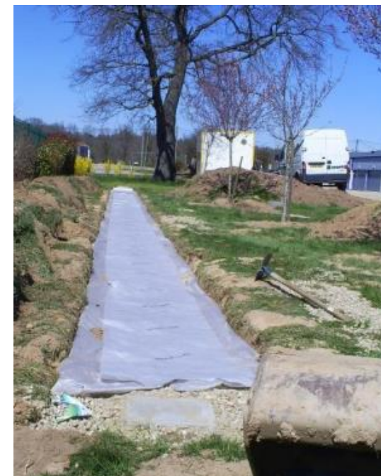
Fermeture du géotextile
