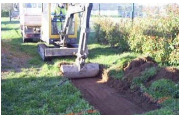
Décapage de la terre végétale
