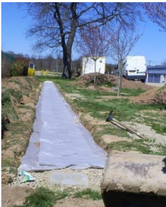
Fermeture du géotextile
