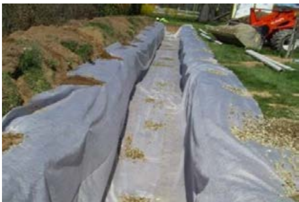
Mise en place du géotextile
