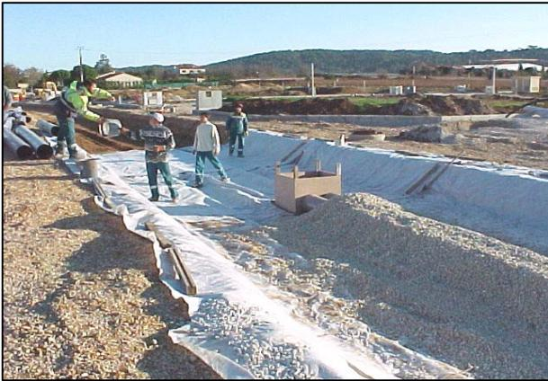
▶ Préparation de la structure réservoir – DDE 34
