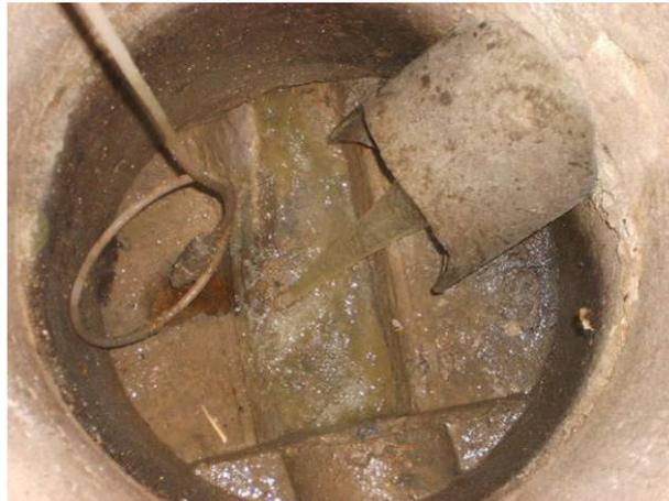
Traces de corrosion du béton
