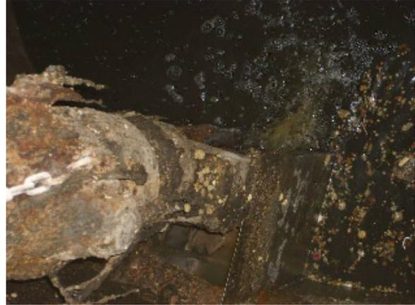
Traces de corrosion du béton et des équipements
