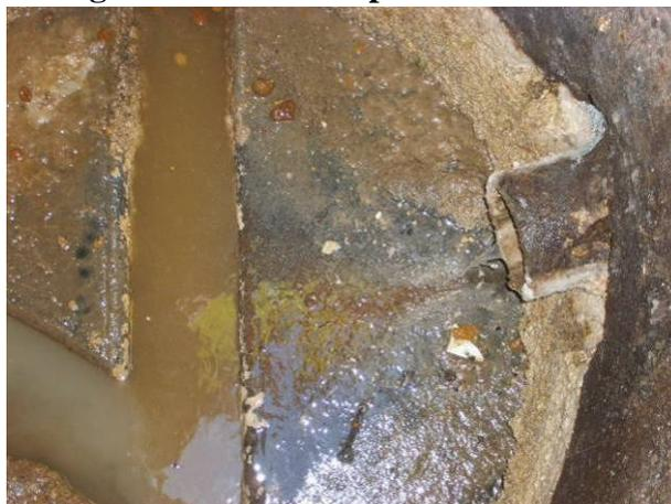
Traces de corrosion du béton
