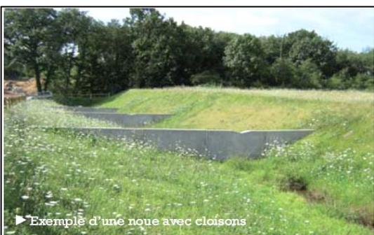
▶ Exemple d'une noue avec cloisons
