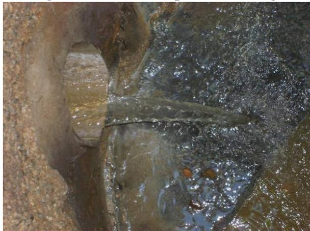
Traces de corrosion et de désagrégation du béton
