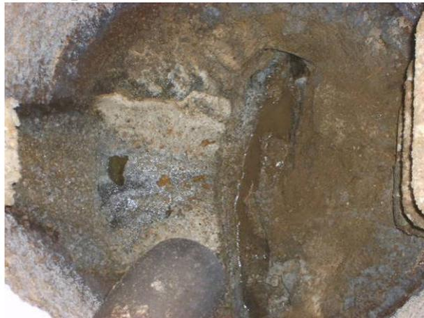
Traces de corrosion du béton
