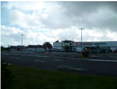
- Surface commerciale Rte de Bangor -
