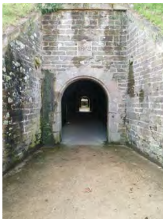
- Fortifications Vauban - LE PALAIS -
