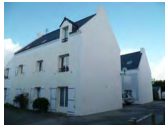
- Logements collectifs à Locmaria -
